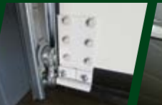
Cable break safety device (Pegaso L.) Parachute contre la rupture des câbles Paracaídas contra la rotura de cables
